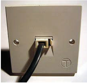
شكل (5): توصيل سلك الهاتف بالمقبس
