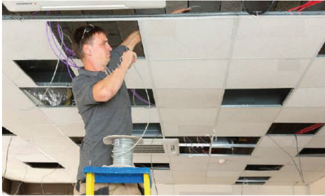
شكل (8): تمديد الأسلاك عبر السقف المعلق
