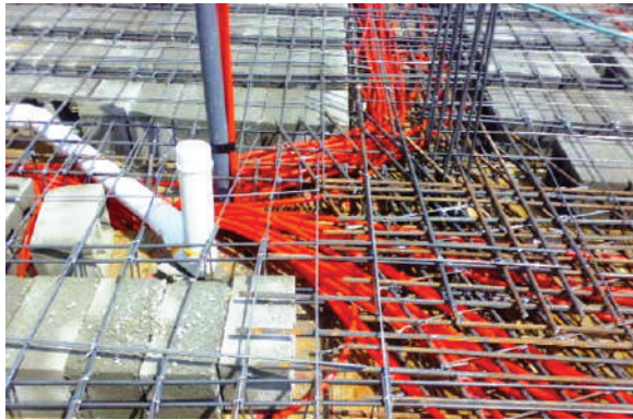
شكل (10): تمديد كابلات الاتصالات عبر أنابيب بلاستيكية
