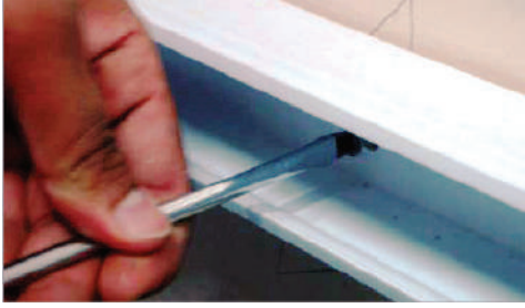
شكل (3): تثبيت الترنك بالبراغي شكل (4): قياس طول قطعة ترنك لتكملة الواجهة
